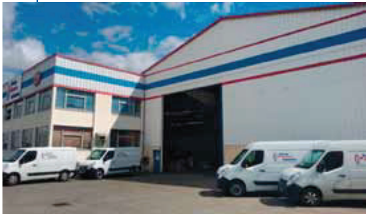
Les 4 800 m 2 de locaux de Vernouillet (28) permettent à Europe service industrie de stocker une grande partie du matériel nécessaire à ses interventions de maintenance (machines, outils, etc.).
